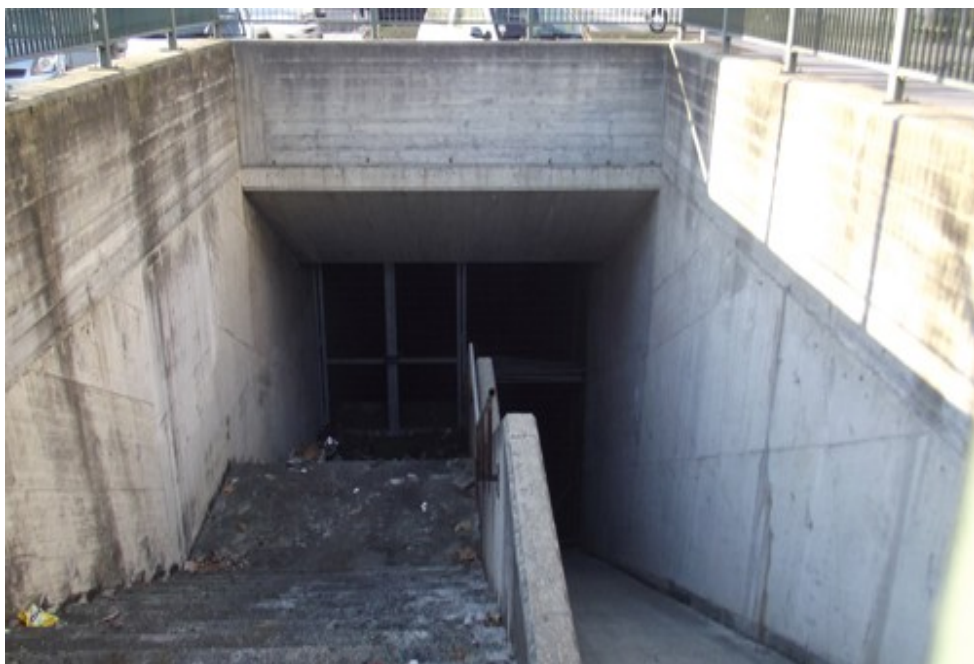
L’ingresso della nuova fermata di Torino Zappata ancora al rustico.
