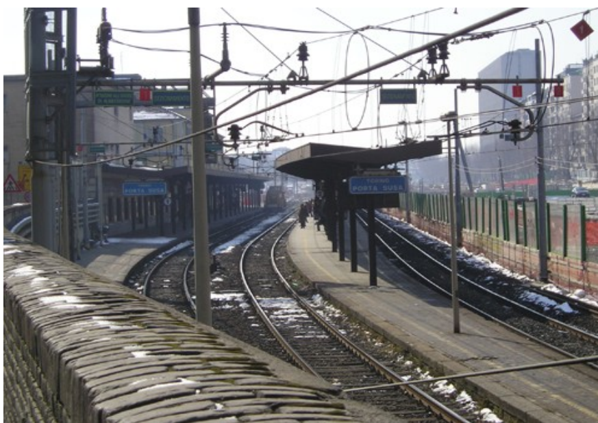
La vecchia stazione di Torino Porta Susa in un'immagine del 2005. Sulla destra si intravedono i lavori della nuova stazione
