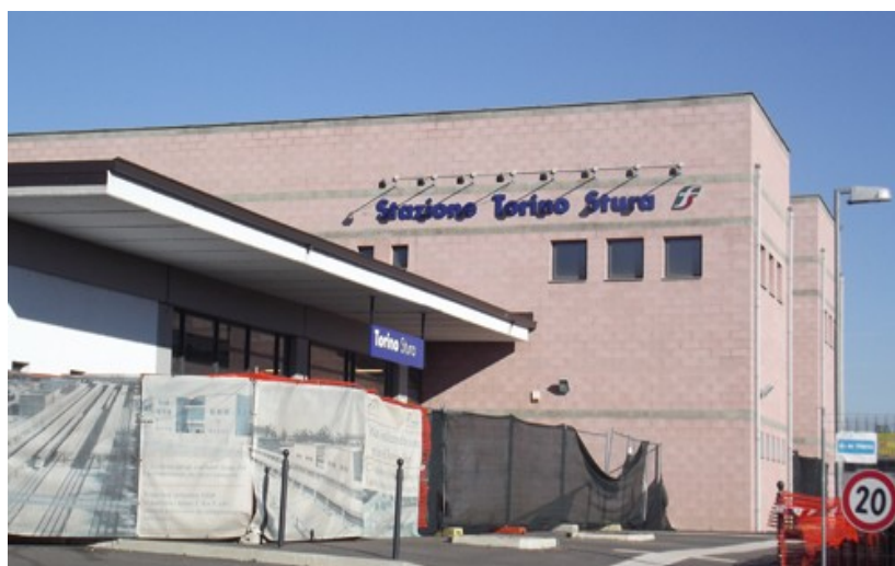
Il nuovo fabbricato viaggiatori della stazione di Torino Stura.
