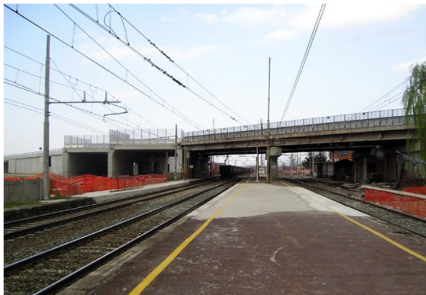
La vecchia stazione di Torino Stura in cui si vedono già predisposti i passaggi per il futuro ampliamento
