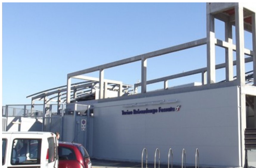
La nuova stazione di Torino Rebaudengo Fossata da domenica 9 dicembre aperta al traffico viaggiatori. Come si può notare, la struttura architettonica esterna non è ancora completata nonostante la stazione sia operativa
